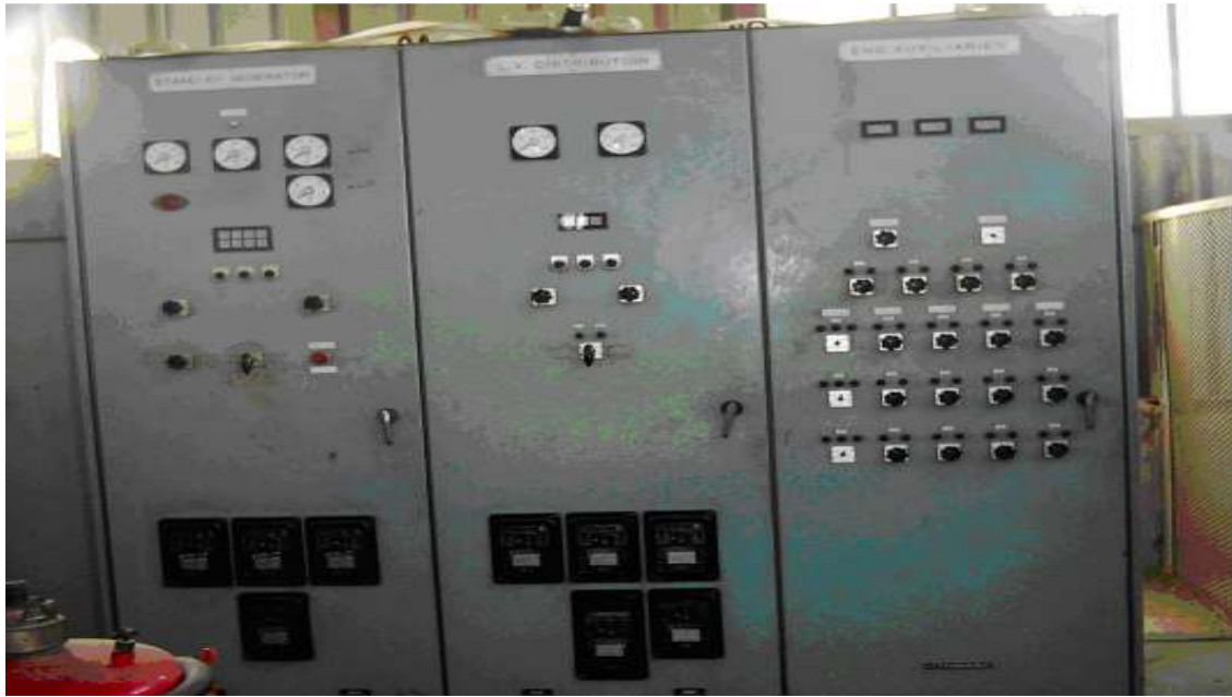
لوحة توتر منخفض تتغذى من مولد وتوزع التيار إلى الأقسام المختلفة
