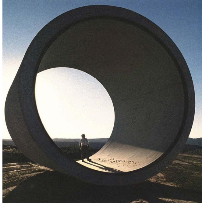
الشكل (1.3) إحدى الأنابيب الخرسانية الضخمة المستخدمة في نقل المياه
