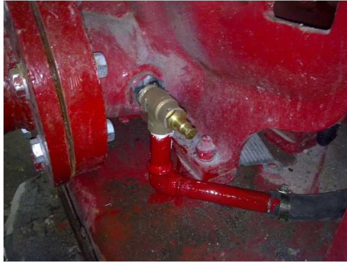
fig-6. casing relief valve
