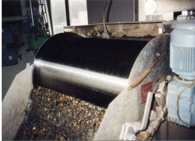
الشكل (2-6): صورة تبين مصفأة دورة طبلية
