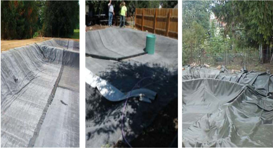
الشكل (3-40): يبين صور عزل الأحواض باستخدام رقائق من البولي اتيلين أو PVC
