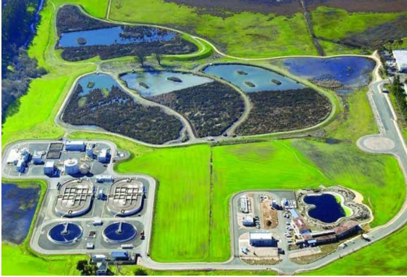
الشكل (3-27): تظهر فيه طريقة المعالجة بالأراضي الرطبة كمرحلة معالجة ثالثة
