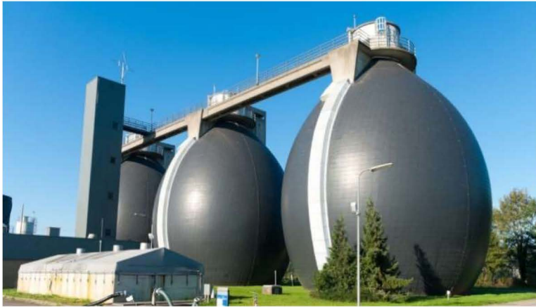
الشكل (5-5): صورة تبين هاضماً لاهوائياً ذا شكل بيضوي
