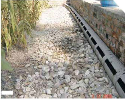
مدخل مياه الصرف مدخل من الأنابيب المشققة
