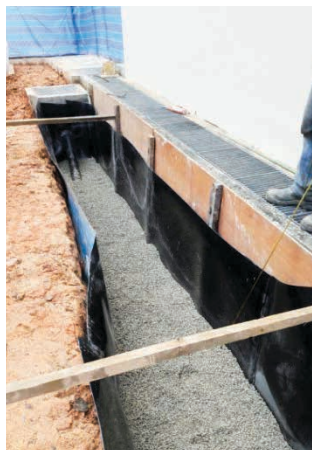
Fig. 5.3 Drainage layer
