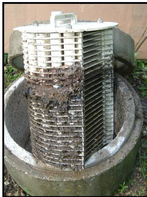
A dirty EFFLUENT screen.
