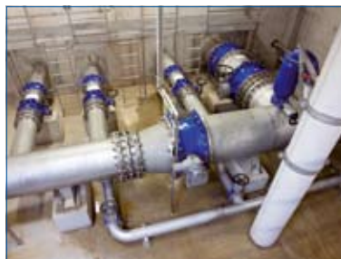
Fig. 4.1.1.2 b: Valve chamber
