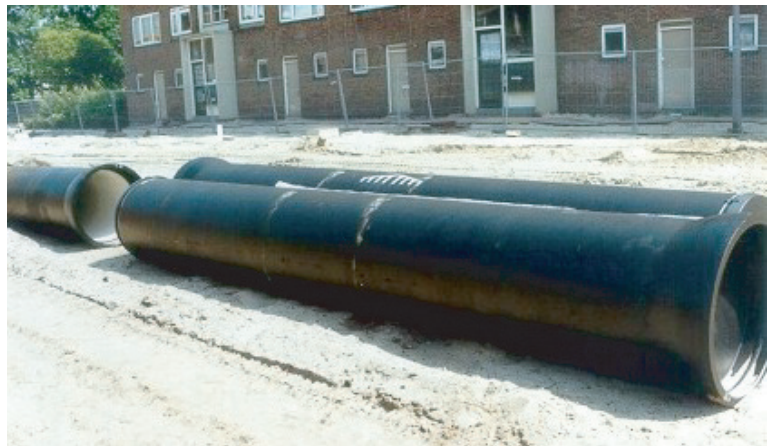
Figure 4.35. DI pipe length.
