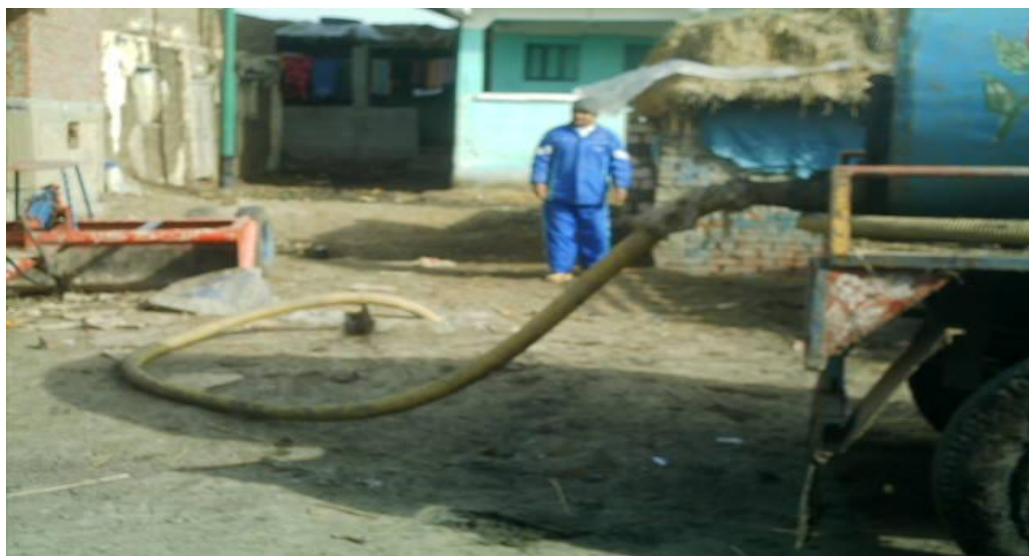
Voiding a trench
