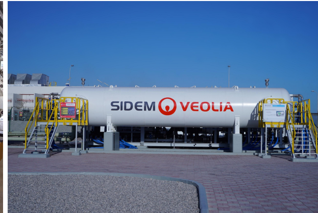
Oman, Sur - SWRO BARREL™ B7 - 1 x 5 000 m 3 /d
