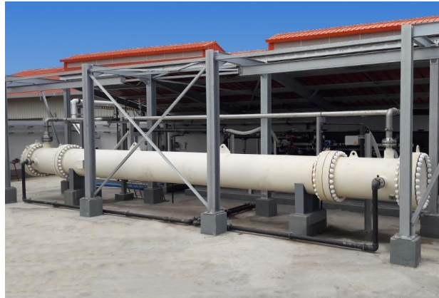
St Martin - SWRO BARREL™ B1 - 1 x 800 m 3 /d unit
