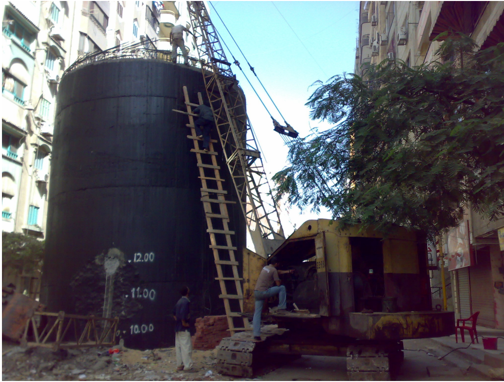
صورة من الطبيعة لأحدي البيارات الخرسانية أثناء التغويص بالكباش
