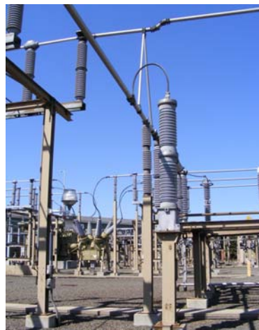
Fig. 20. 345 kV CCVT
