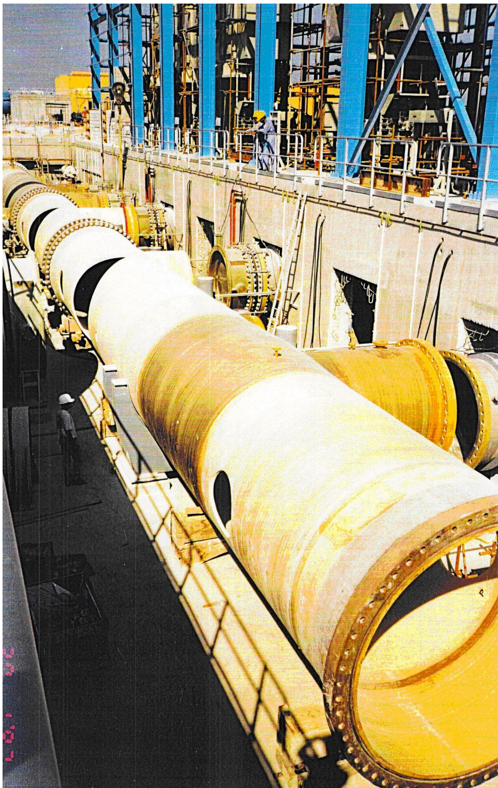
شكل (٣٨) خط مجمع لظلمبات رفع مياه الصرف
