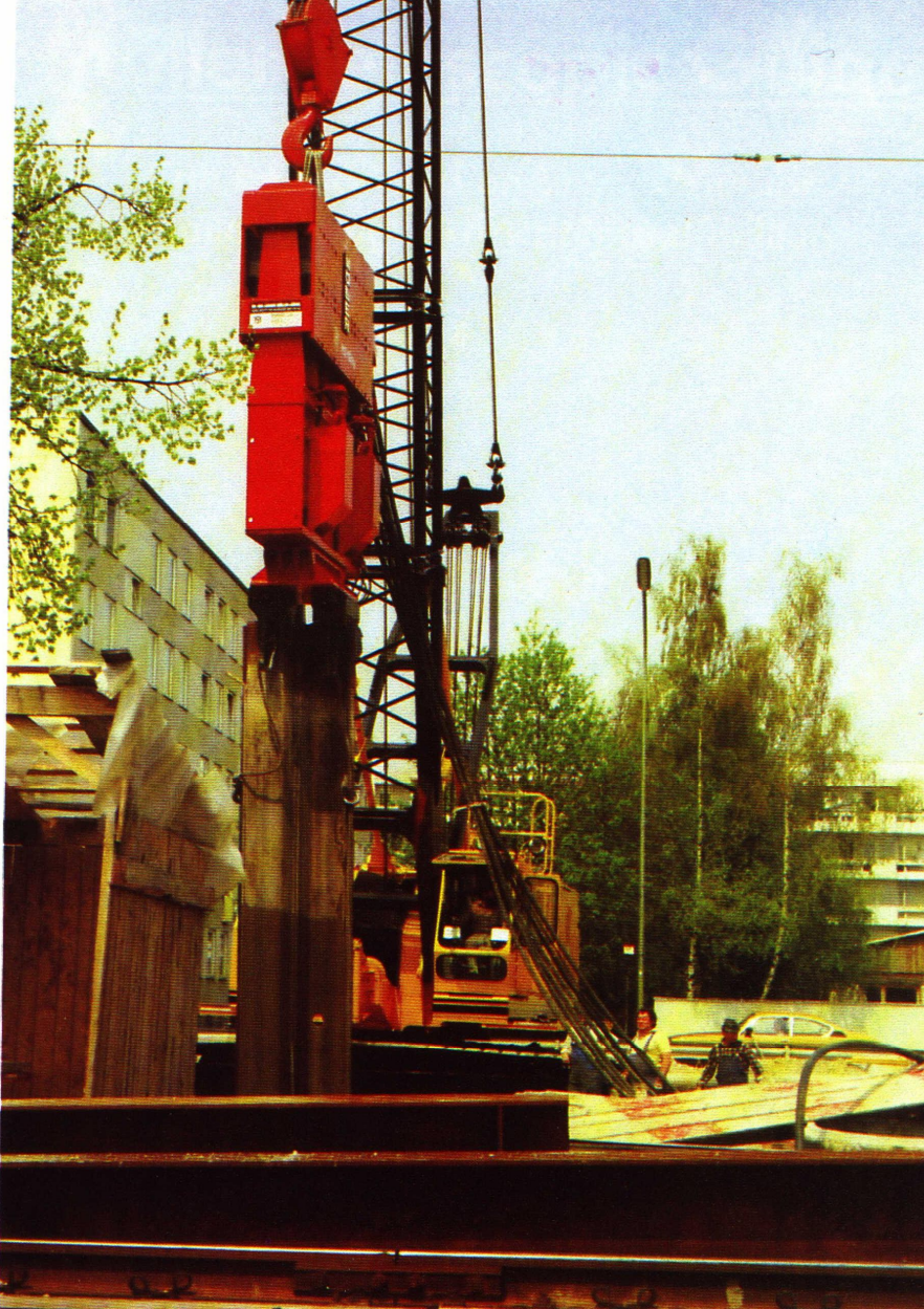
شكل (١٠-١٤) تفاصيل الهزاز
