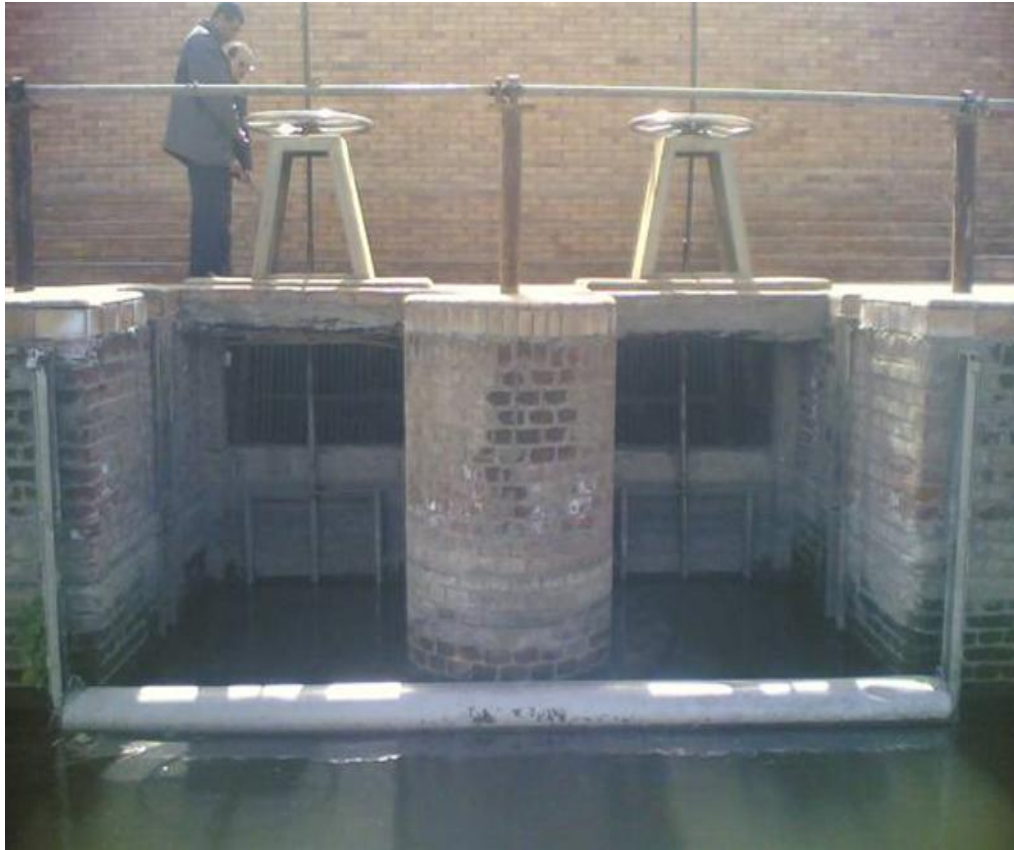
شكل توضيحي لمأخذ شاطئ
