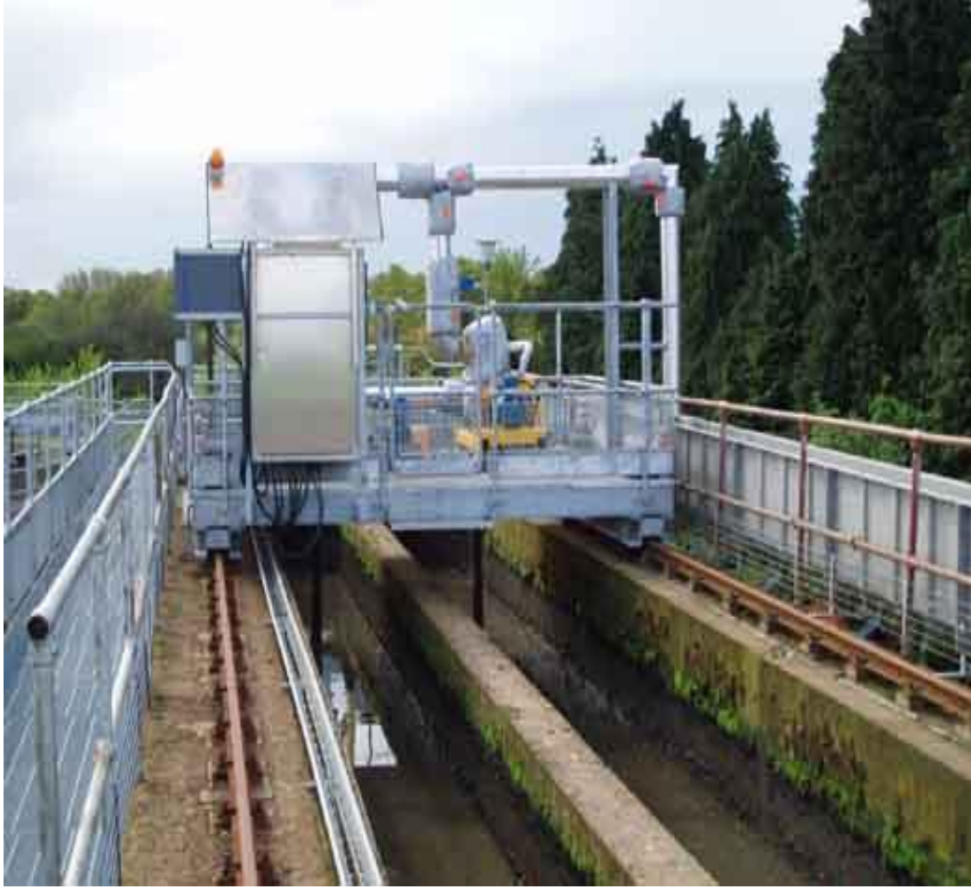
شكل رقم (٩) تفاصيل أحواض فصل الرمال
