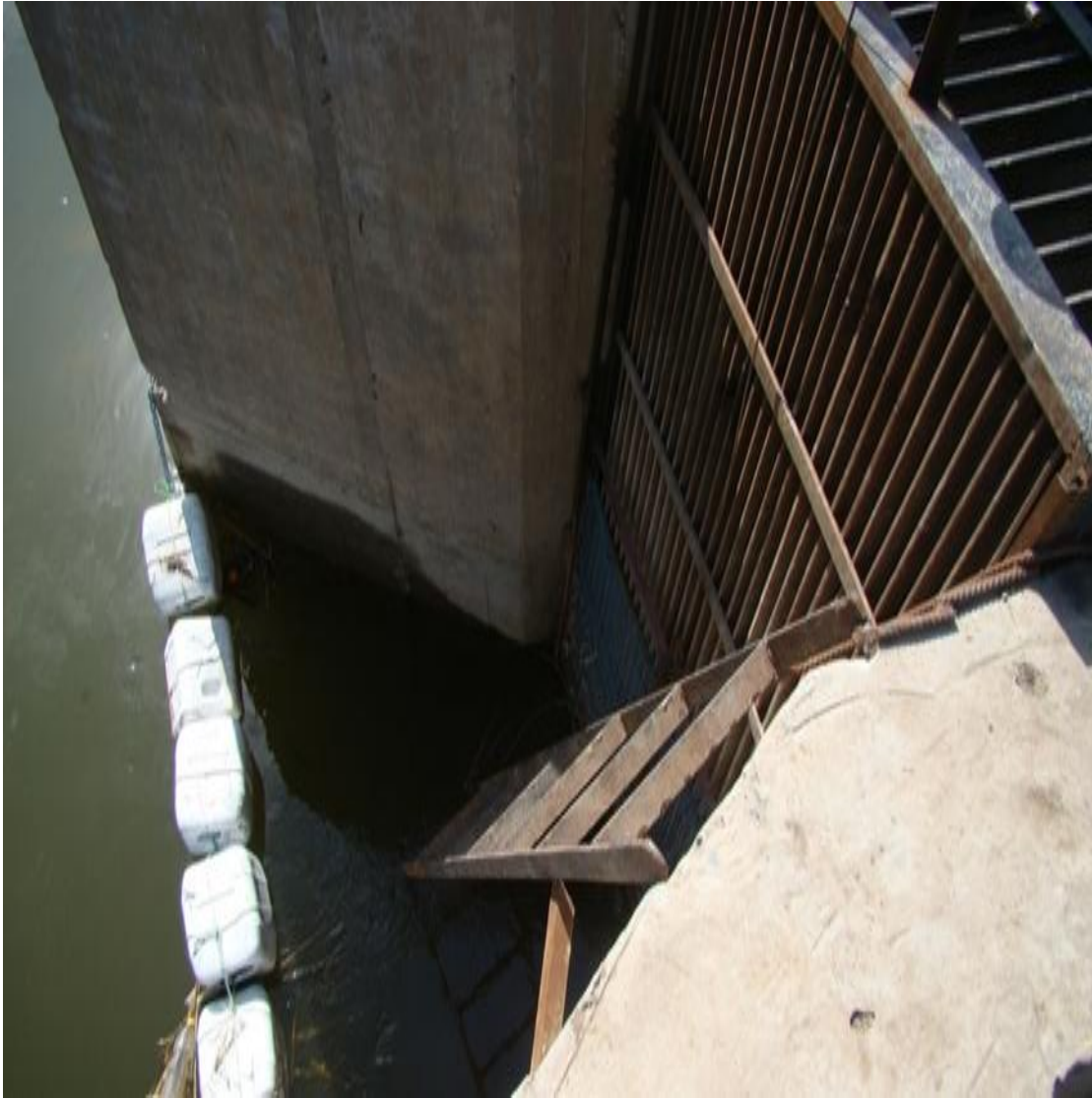
شكل توضيحي للمصافي ذات القضبان
