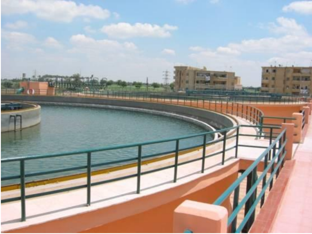
المروق - أهم مكونات محطة المعالجة
