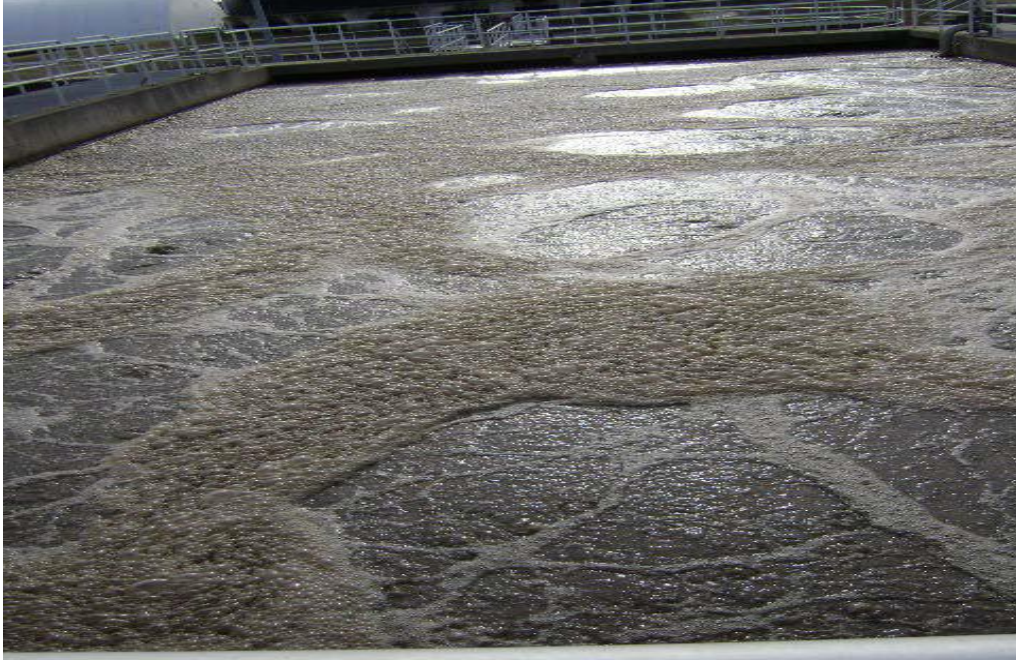
شكل رقم (٥-٦) وجود رغاوى سمراء بحوض التهوية
