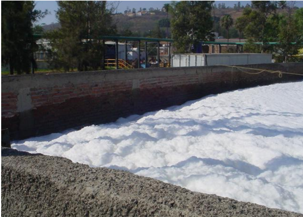
شكل رقم (١-٥) وجود رغاوى بيضاء بأحواض التهوية في بداية التشغيل
