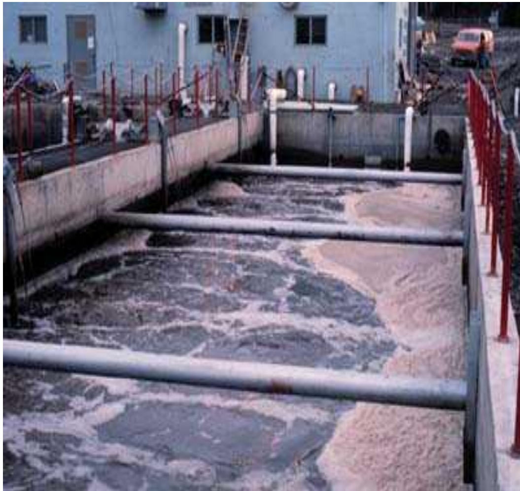
شكل رقم (٥-٣) بداية ظهور الرغاوى البنية بحوض التهوية
