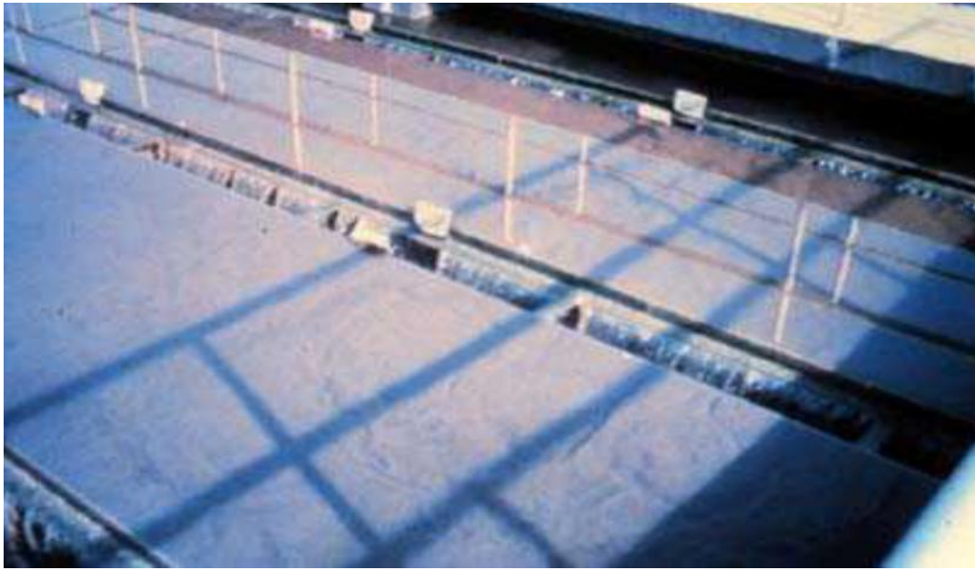
شكل رقم (٥-٩) أن سرعه ترسيب الحمأة بطيئة جدا
