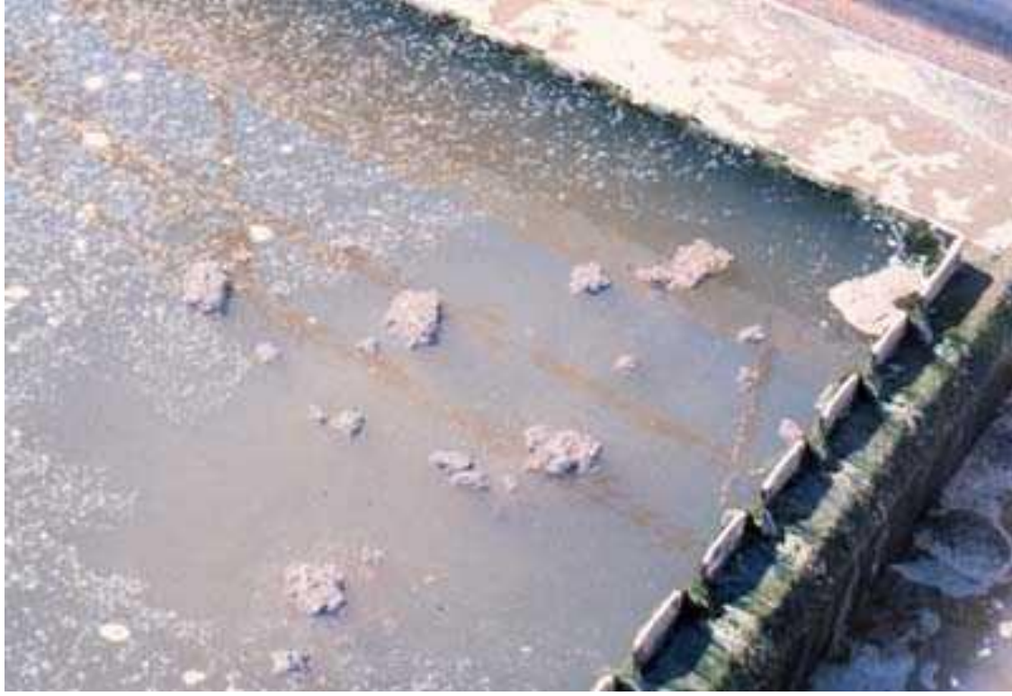
شكل رقم (٧-٥) وجود فقاعات غاز النيتروجين بالحماة وطفوها على السطح
