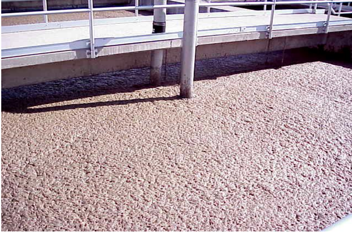
شكل رقم (٥-٤) وجود رغاوى بنيه كثيفه بحوض التهوية
