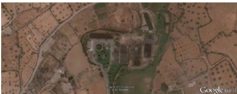
الشكل 2 : محطة معالجة مياه الصرف الصحي الوردانين (غوغل إيرث 2015) (WWTP Ouardanine (Google Earth 2015))
