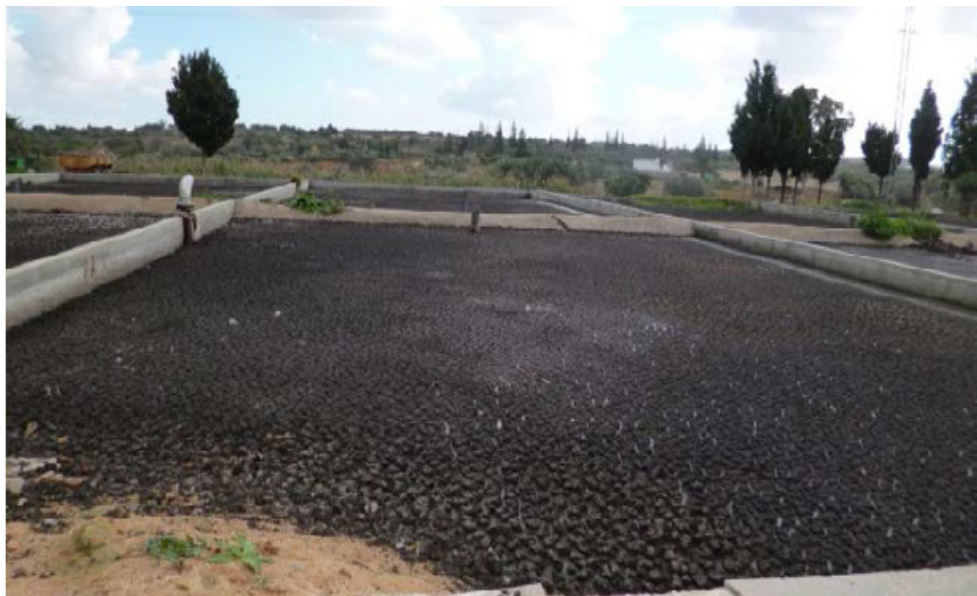
الشكل 4 : حمأة المجاري في حقول التجفيف في محطة معالجة مياه الصرف الصحي WWTP في الوردانين Ouardanine (بإذن من محجوب 2015) (with permission of O. Mahjoub 2015).
