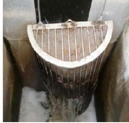
الشكل 7: شبكة مركبة في مخرج محطة معالجة مياه الصرف الصحي WWTP في الوردانين Ouardanine في عام 2003 (يسار) والمنخل الجديد، والشبكة التي تم تركيبها في عام 2004 (يمين) (بإذن من محجوب، 2003، 2015) (with permission of O. Mahjoub, 2003, 2015).
