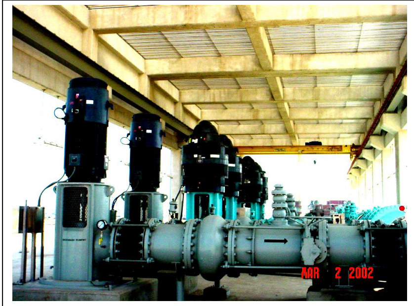
شكل رقم (١٥) طلبات المياه المرشحة
