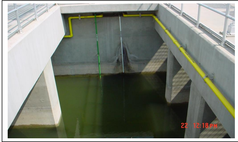
شكل رقم (٤) بيارة المياه العكرة
