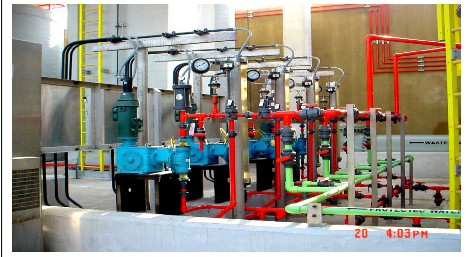
شكل رقم (١١) مضخات حقن محلول الشب
