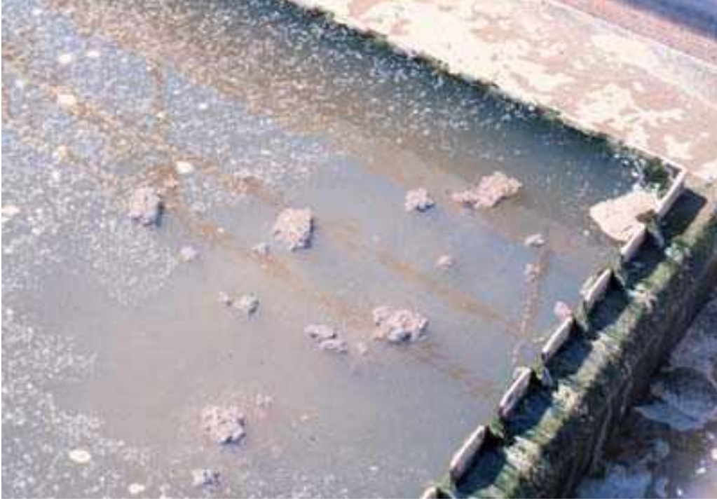
شكل رقم (٥-٧) وجود فقاعات غاز النيتروجين بالحمأة وطفوها على السطح
