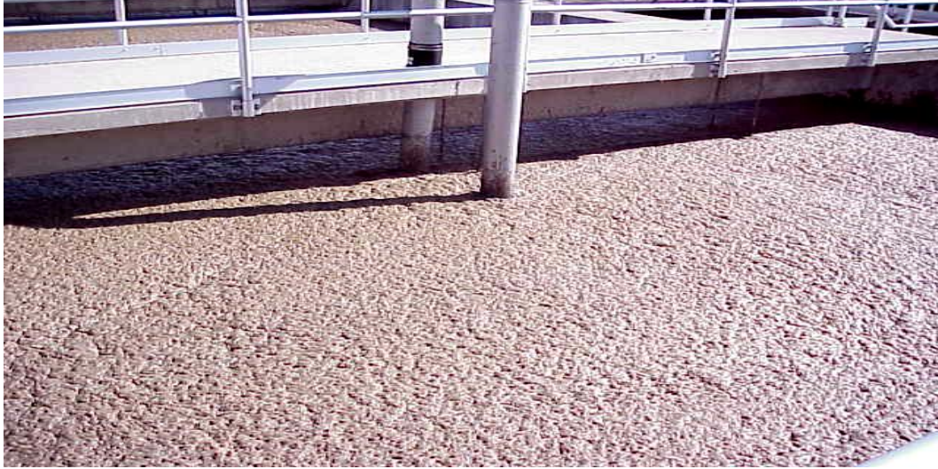
شكل رقم (٥-٤) وجود رغاوى بنيه كثيفه بحوض التهويه
