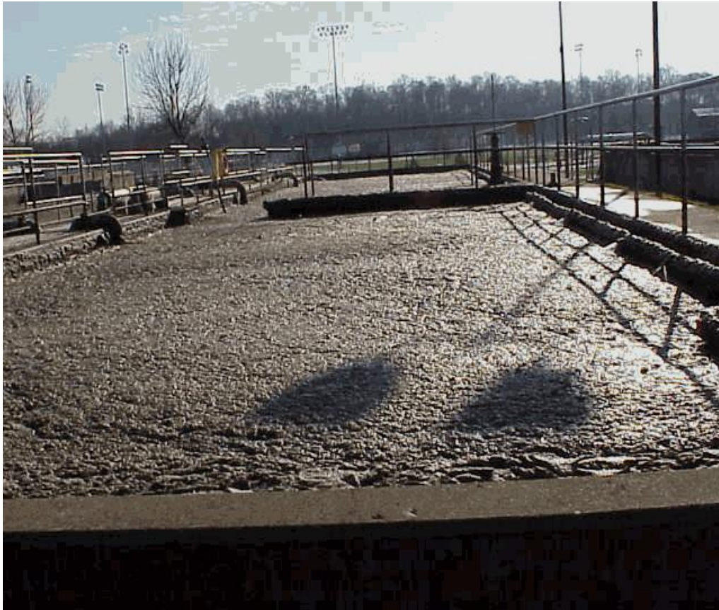
شكل رقم (٥-٤) وجود رغاوى بنيه كثيفه و قاتمته تميل إلى اللون الأسود
