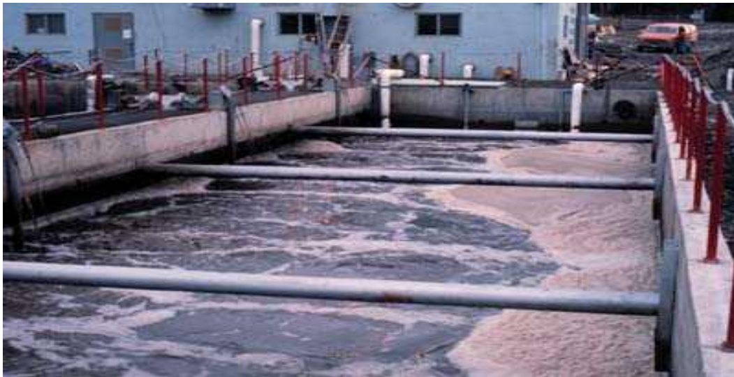
شكل رقم (٣-٥) بدايه ظهور الرغاوى البنيه بحوض التهويه
