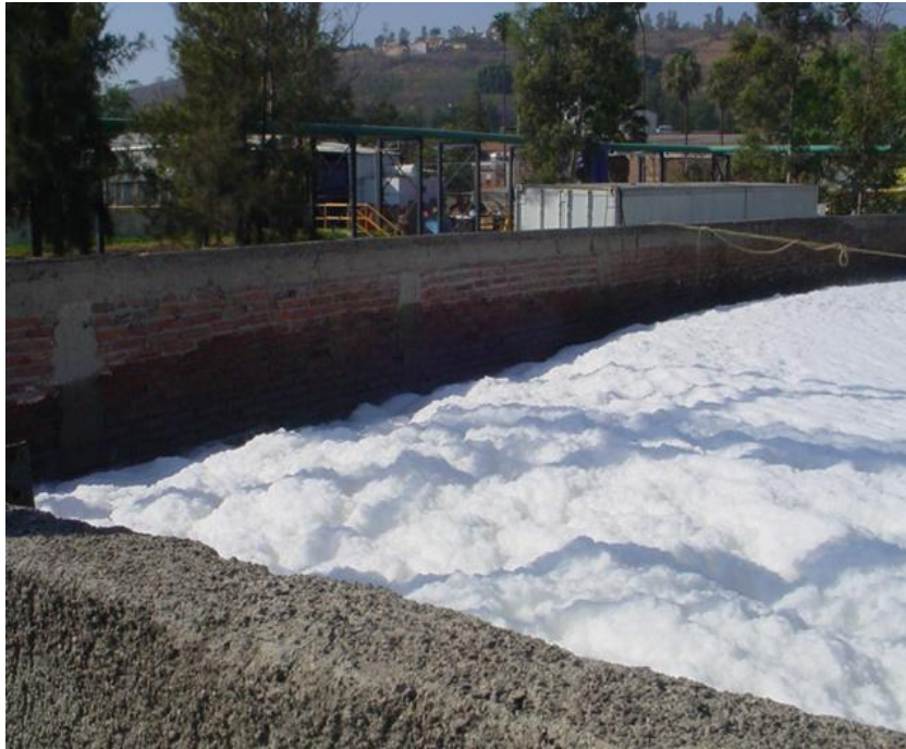
شكل رقم (٥-١) وجود رغاوى بيضاء بأحواض التهويه فى بدايه التشغيل
