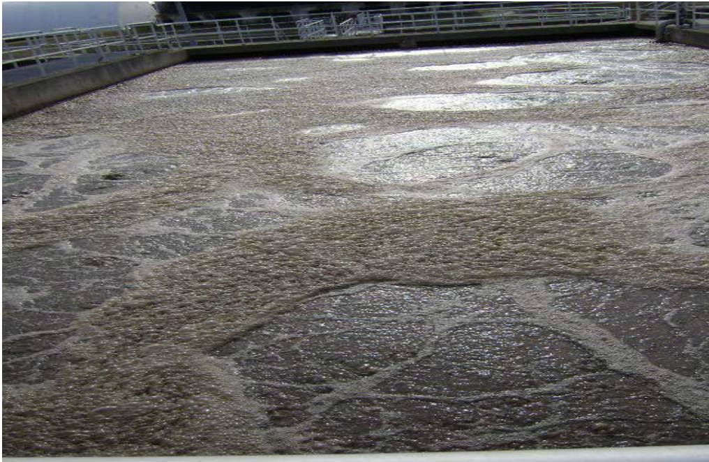
شكل رقم (٥-٦) وجود رغاوى سمراء بحوض التهويه
