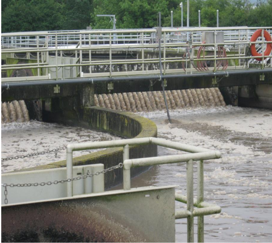
يوضح الشكل رقم (٥-٢) وجود رغاوى بيضاء نتيجة انخفاض MLSS وزيادة F / M وانخفاض عمر الحمأ بالمحطة
