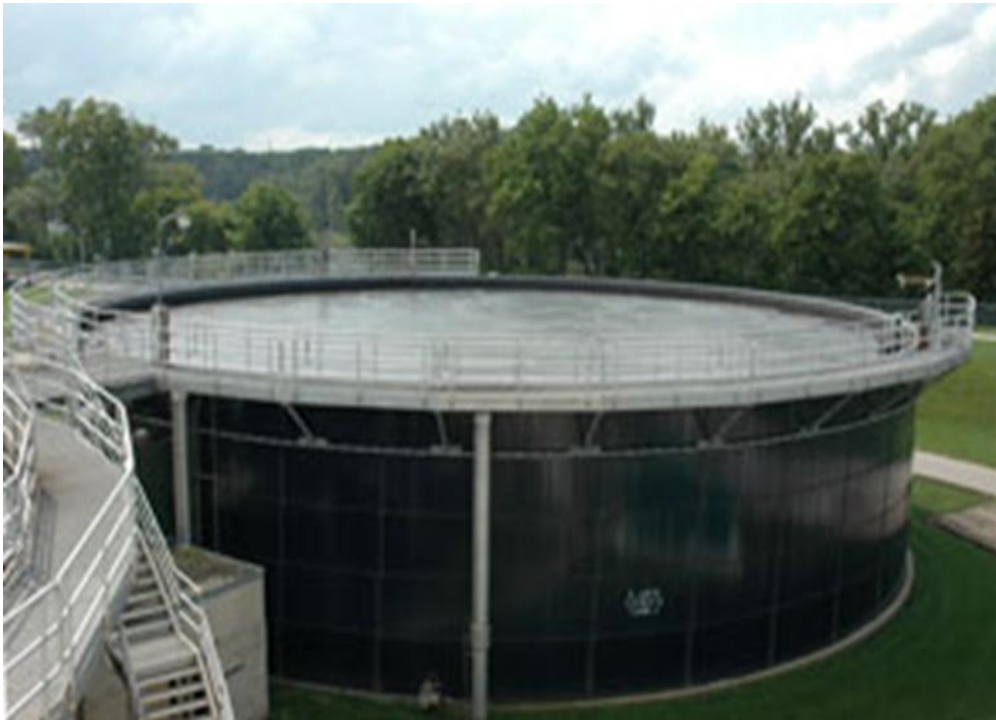
صورة رقم ١ توضح حوض التكتيف الدائري الشكل
