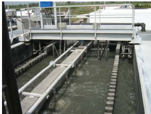
مستوي المياه بالمدخل
