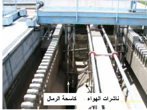
صورة رقم (٢-٦) أحواض فاصل رمال مهوي مستطيل الشكل
