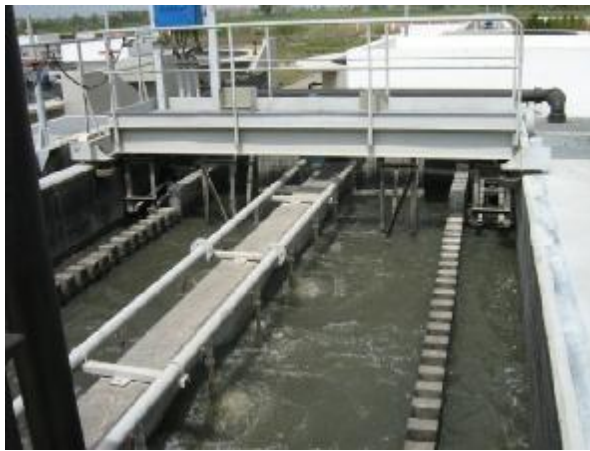
صورة رقم (٢-٧) كوبري أحواض إزالة الرمال
