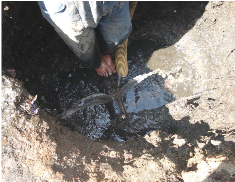
صورة رقم (٣) توضح أحد التسربات بخط
