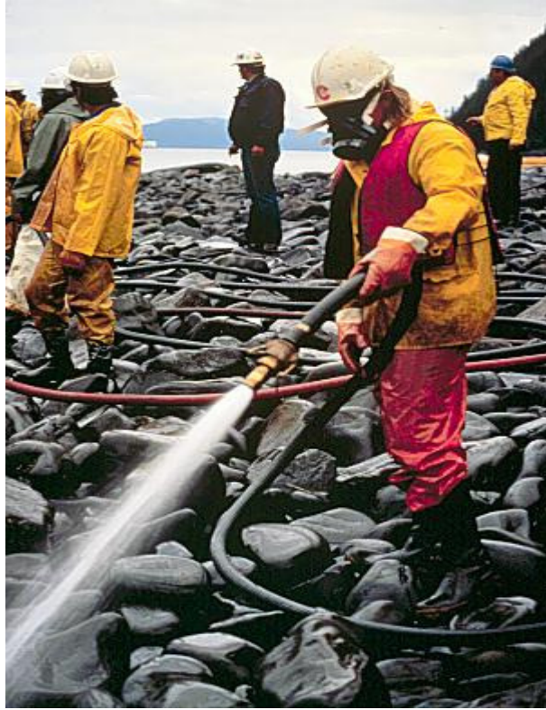
تنظيف الشواطئ البحرية الملوثة بالنفط باستخدام المياه الساخنة المضغوطة
