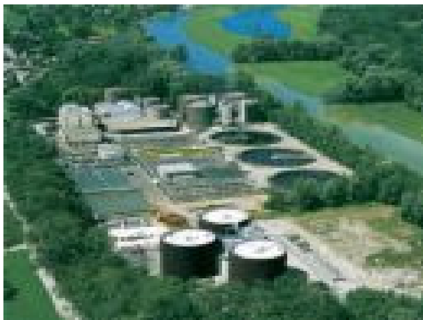
محطة معالجة مياه الصرف الصحي
