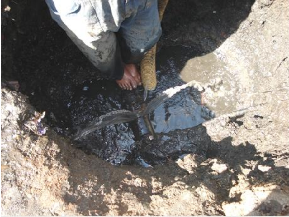
صورة رقم (3) توضح أحد التسربات بخط إسيستوس
