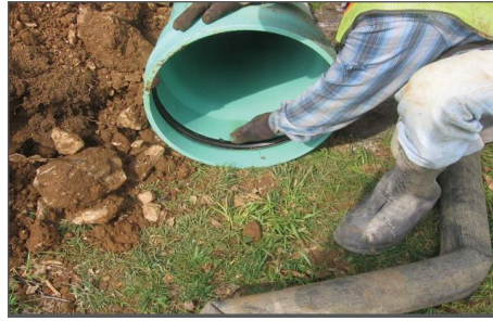
الشكل (6-49) شطف طرف الأنبوب وتركيب حلقة التسرب
