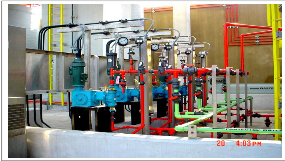
شكل رقم (١٦) مضخات حقن محلول
