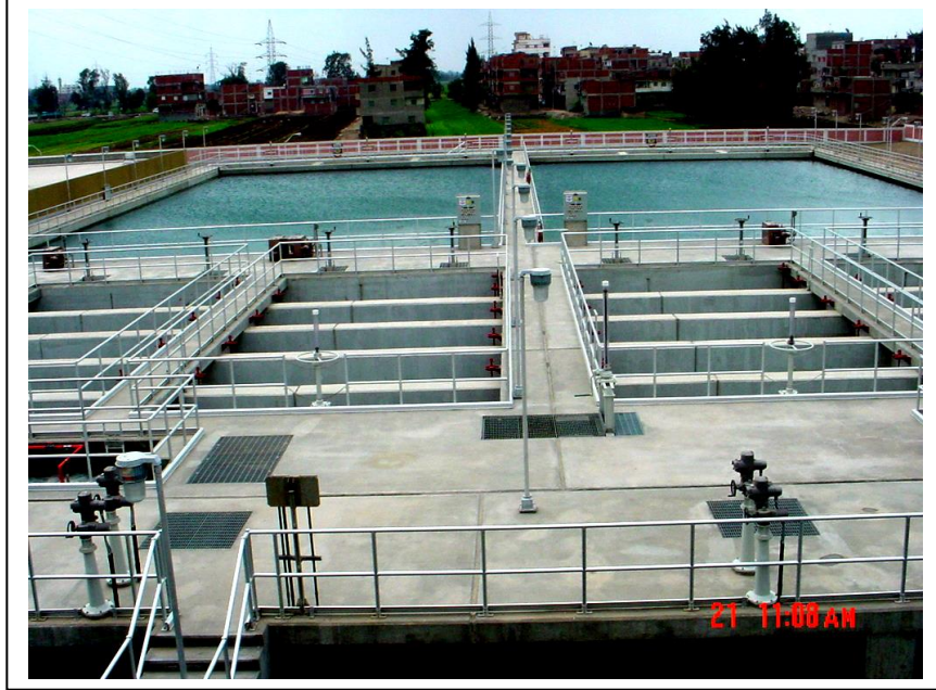
شكل رقم (١٧) حوض الترويب والترويق المشتركة
