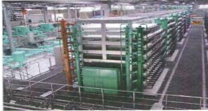
شكل 24- منظومة أغشية الفلاتر فائقة الترشيح (UF) التي تعمل بالضغط في محطة فوكوكا-اليابان لتحلية مياه البحر
