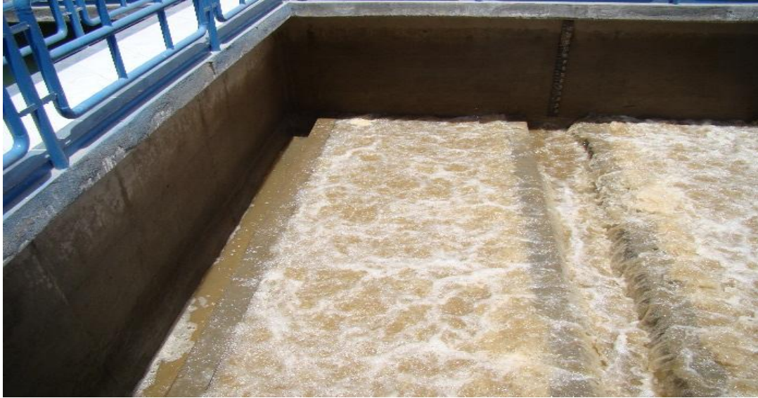
فقد الوسط الترشيحي اثناء الغسيل ١
