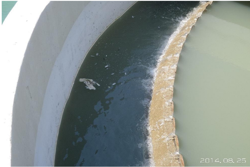
الاسماك في المروقات بسبب عدم تنظيف المأخذ ١
