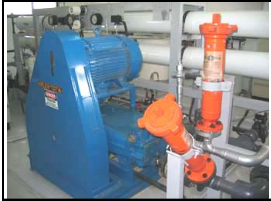
شكل (٧-١) صورة لمضخة ضغط عالي ماركة أبلكس (APLEX)
