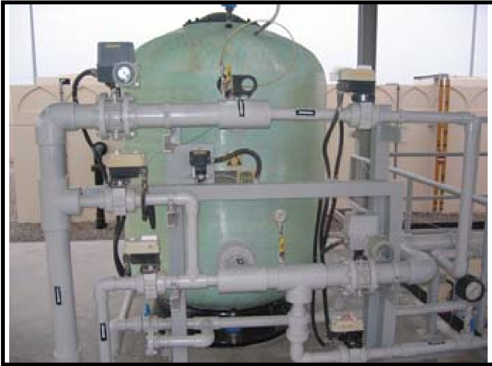
شكل (٤-١) صورة لفلتر متعدد الطبقات
