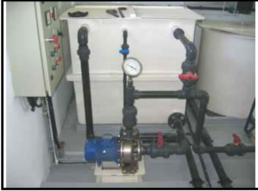
شكل (١١-٢) صورة لخزان ومضخة الغسيل الكيميائي
