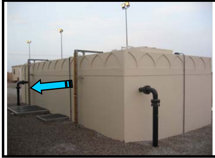
شكل (٥-١) خزان المياه المفلتر
