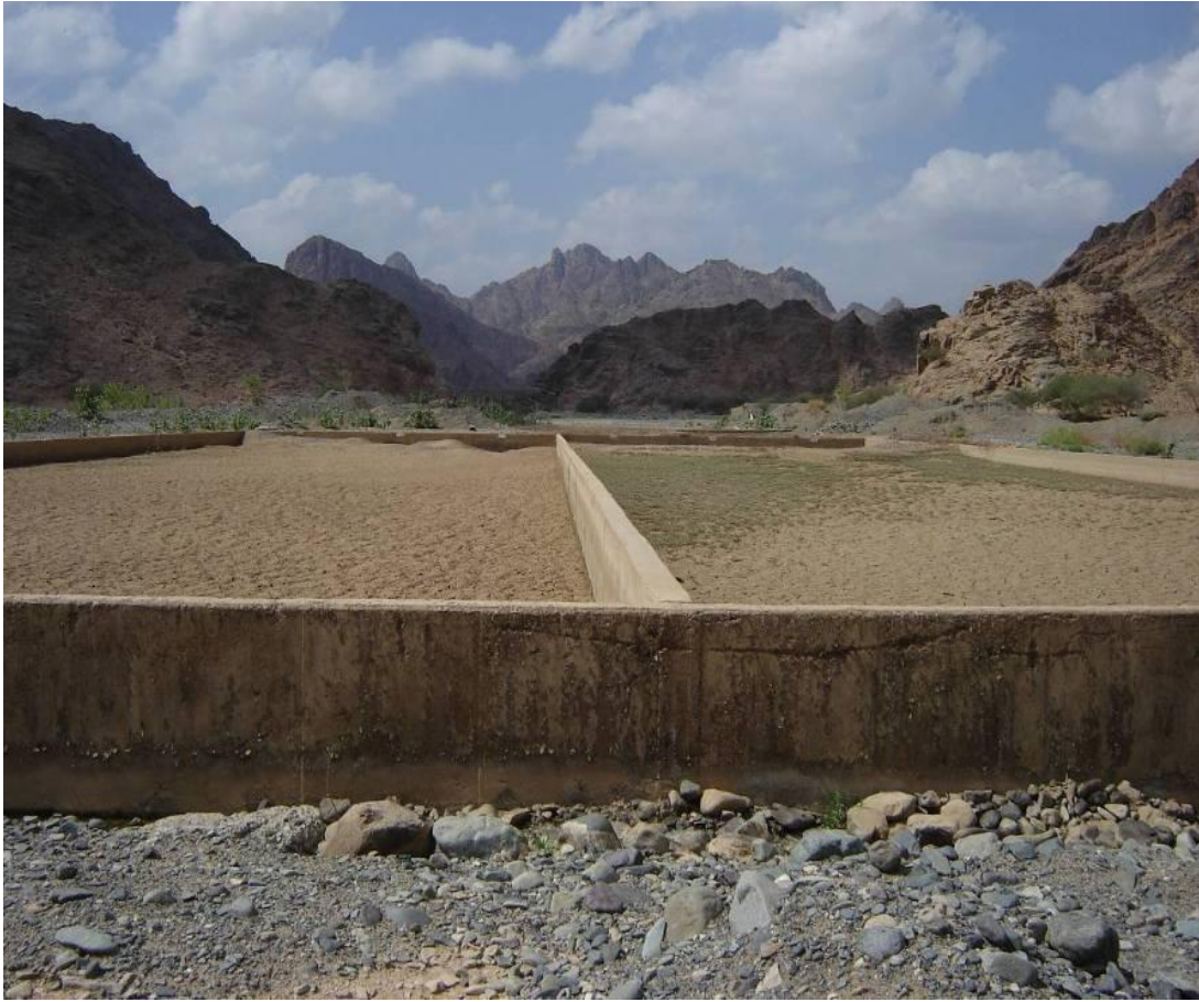
الشكل رقم (٢-٢٨) تفاصيل المرشحات الرملية البطيئة المعدل
