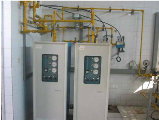
الشكل رقم (١٠-٢٣) اسطوانات الكلور وجهاز حقن الكلور (الكلورينيتور)
