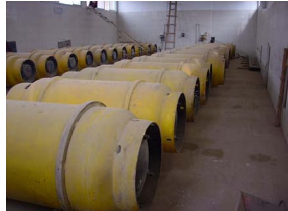
الشكل رقم (١٠-٢٣) اسطوانات الكلور وجهاز حقن الكلور (الكلورينيتور)
