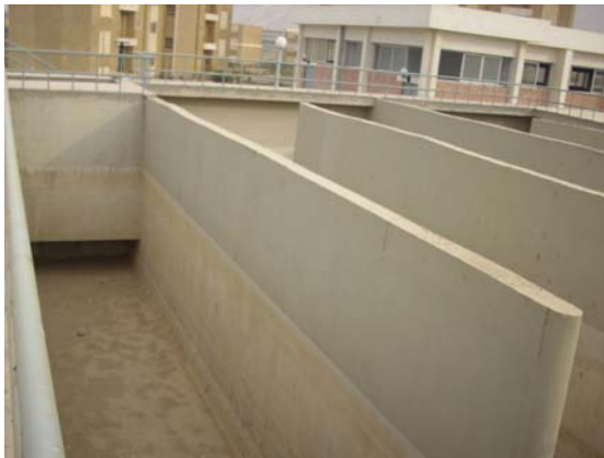
الشكل رقم (١٠-٢٤) ظلمبات البوستر وأحواض تلامس الكلور
