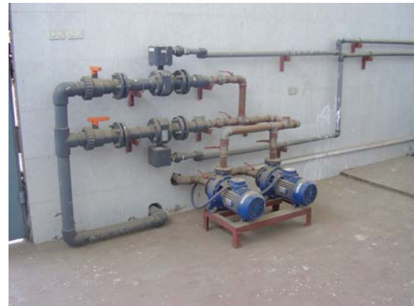
الشكل رقم (١٠-٢٤) ظلمبات البوستر وأحواض تلامس الكلور
