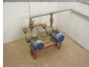
بلاورات هواء لسحب غاز الكلور المتسرب وظلميات الصودا
