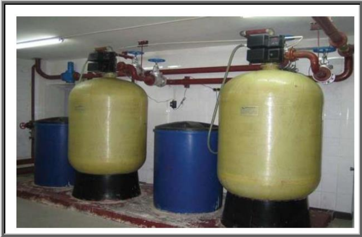
3- استخدام نظام 2 فيزل مع بعضهما أى Twin system مثل التوأم وهى نفس فكرة ال-2 vessels وصورته كالتالى:
