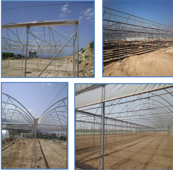
صورة (٦): توضح إنشاء هياكل الصوب
