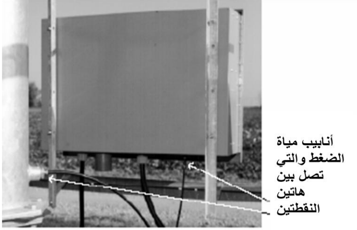
شكل ٩٨ : وصلة المياه الى لوحة التحكم عبر انبوب اسود اللون.
