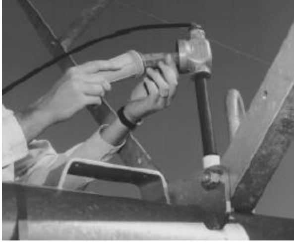
شكل ١٥٧: تنظيف مصفاة الصمام اللولبي الكهربائي
