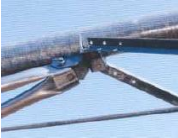
شكل ٢٩: أنابيب سميكة الجدار ومواسير جانبية ونصف قطرية ملحمة تعطي ثباتا للمحور.
