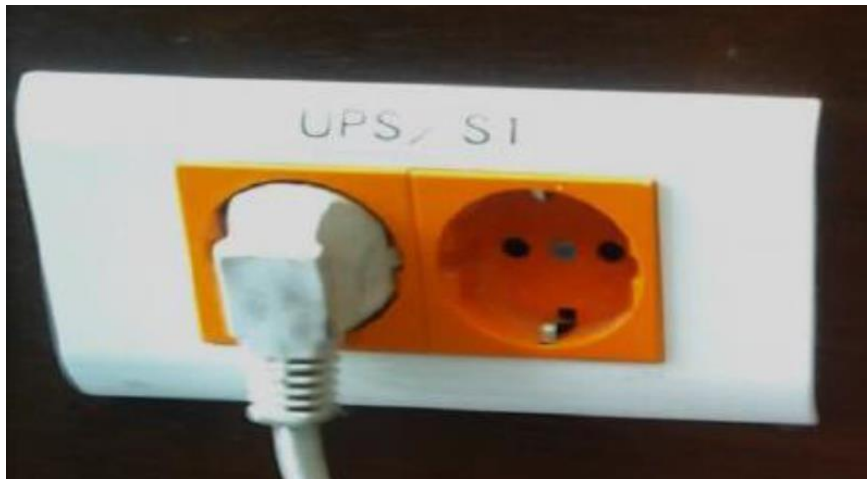
شكل رقم ٩٤: مقبس UPS مزدوج
