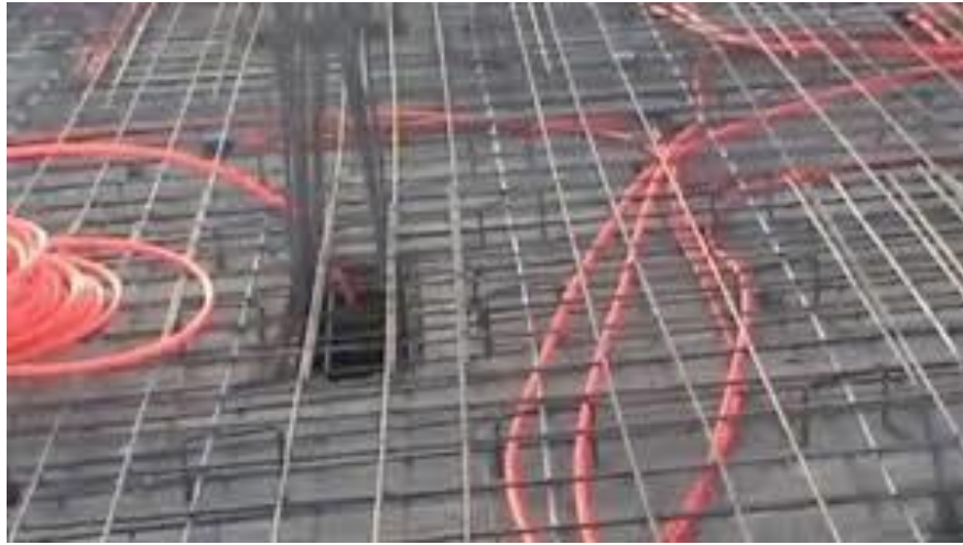
شكل رقم ٨٣: صورة توضح تجهيز المواسير
