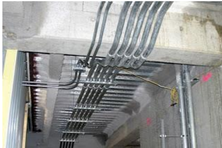
شكل رقم ٨١: صور عن مواسير الحديد وتمديداتها
