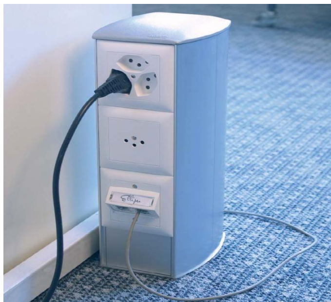
شكل رقم ٩٩: المقابس (البراييز) المصفوفة (Column Sockets)
