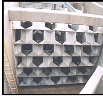
شكل (١٤-٢) الخلط الإستاتيكي بالقنوات المفتوحة
