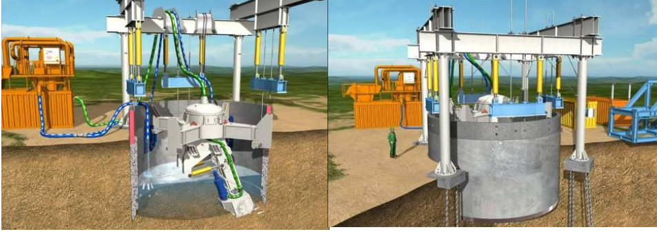
شكل (٧-٦) طريقة تنفيذ الغرف بطريقة الحفر الرأسي
