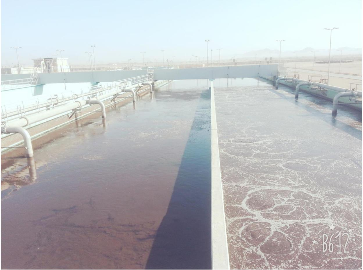
تشغيل حوض التهوية رقم (3) بطريقة النترة / نزع النترة المتزامن simultaneous nitrification/denitrification
