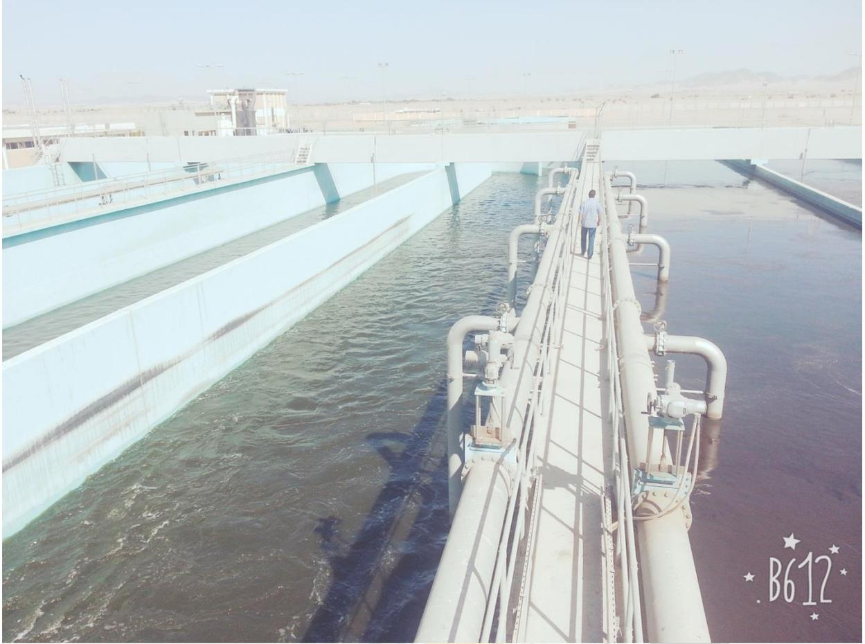
في حالة التشغيل بطريقة نزع النترة المتزامن simultaneous denitrification يتم تشغيل الأحواض في وضع التوازي بحيث يكون لكل حوض منطقة هوائية aerobic zone ومنطقة لاهوائية anoxic zone بحيث لا تقل المنطقة اللاهوائية عن 37 % من إجمالي مساحة حوض التهوية
