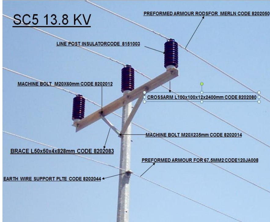
شكل ( ٥٥ - ٤ ) عمود ضغط متوسط بعوازل رفع
