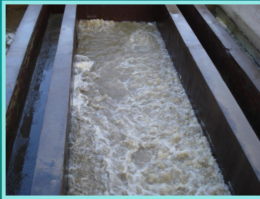
صورة توضح تشغيل البلور (لاحظ منسوب المياه بالنسبة للهدر)
