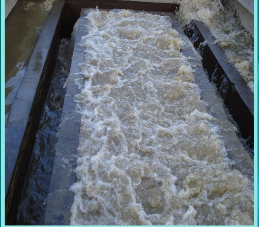
صورة توضح دخول المياه مع الهواء أثناء الغسيل (لاحظ منسوب المياه بالنسبة للهدرات)
