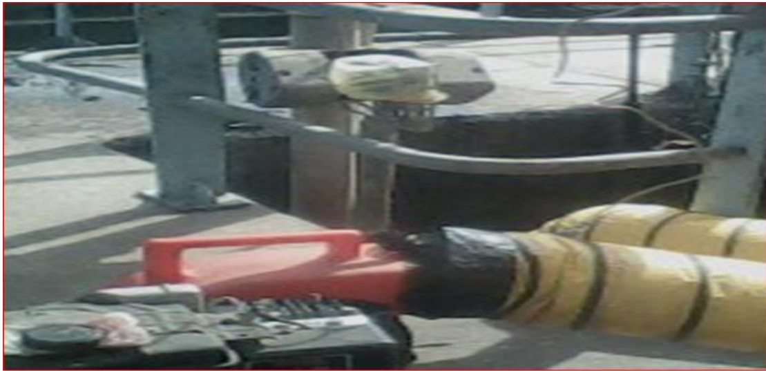
صورة رقم ٣ توضح أجهزة التهوية الصناعية للبئر
