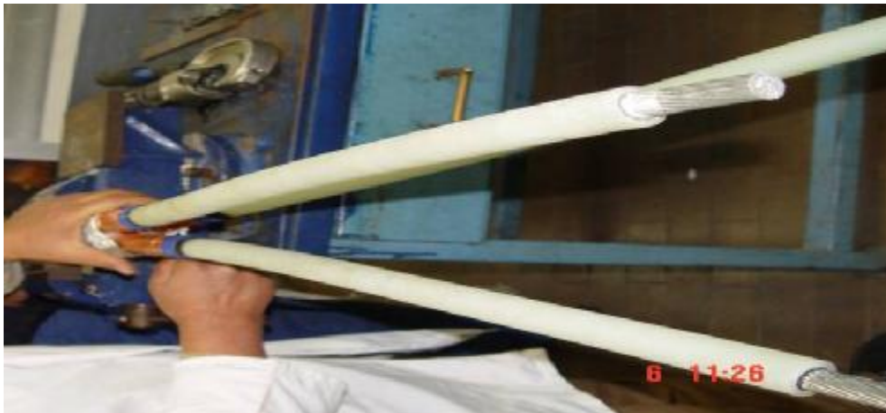
شكل رقم (٥-٦): خطوات عمل نهاية كابل جهد متوسط ثلاثي الأطوار
