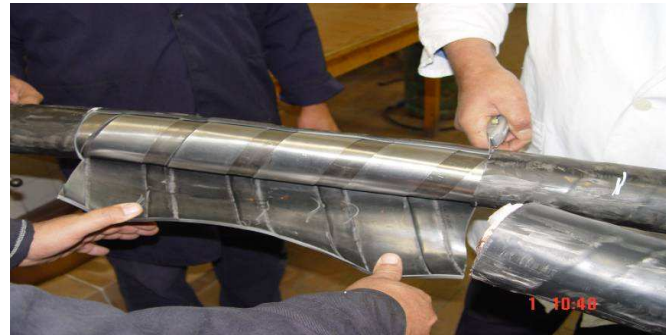
شكل رقم (٥-٨): خطوات إعداد الكابلات لعمل وصلة أرضية لكابلات جهد متوسط
