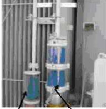
جهاز التنفس للمحول جهاز التنفس لمغير الجهد
