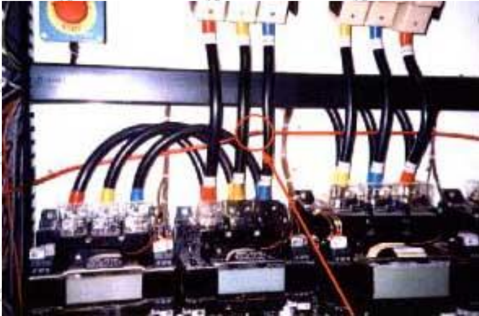
الكاشف الهيدروليكي / أنبوب الإطفاء داخل لوحة التوزيع
