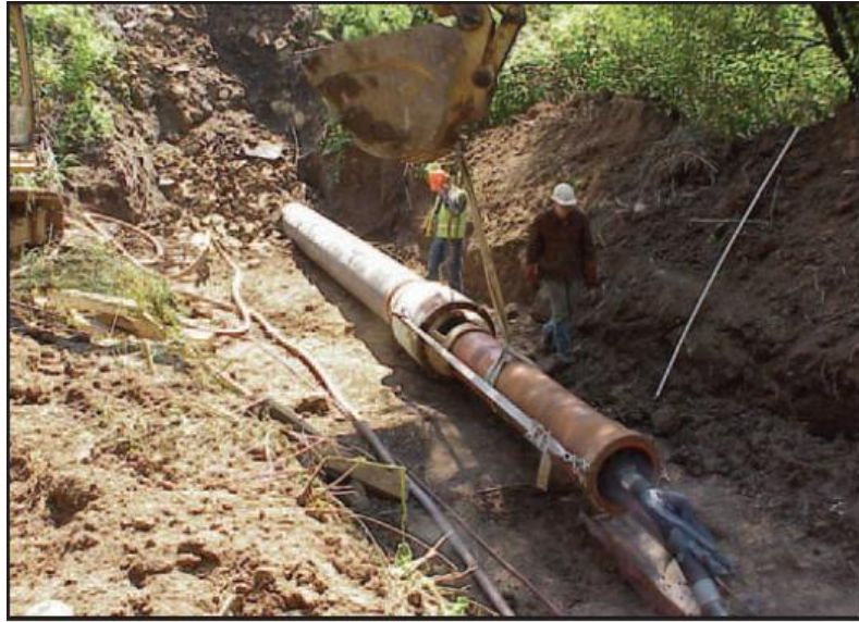
الشكل (١٢) عملية مد انبوب بطريقة الصدم
