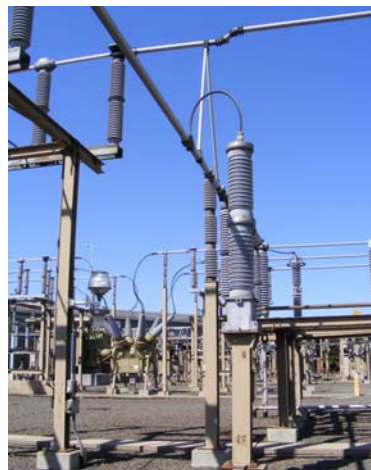
Fig. 20. 345 kV CCVT
